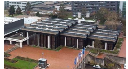
Die Mensa soll im April 2023 wieder eröffnet werden (Bild: Staatliches Bauamt)
